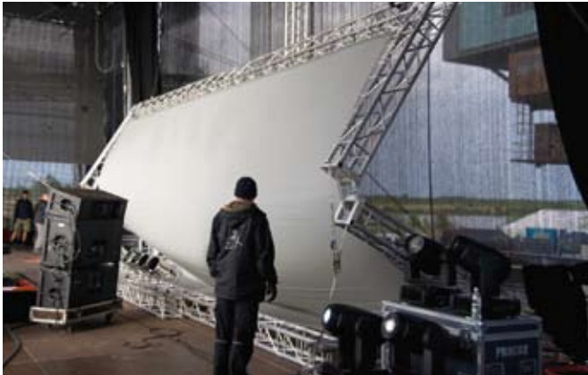
Die faltbare Leinwand erleichterte den Technikern das Auf- und Abbauen und schützte die Opera-Folie
